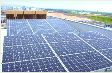
都有施設への太陽光発電設備の導入
