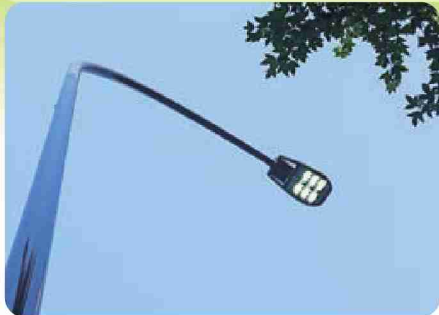
都有施設・道路の照明のLED化
